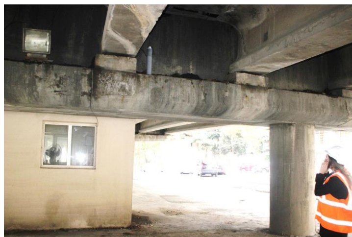
Рис. 5. Фото оборудования на эксплуатируемом мосту
