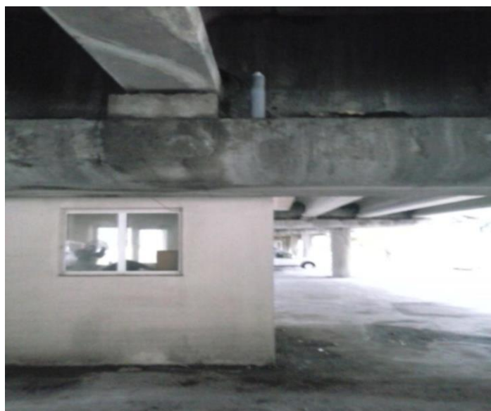
Рис 4. Фото оборудования на эксплуатируемом мосту
